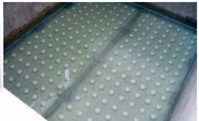
Plancher filtrant / station de Zelai
