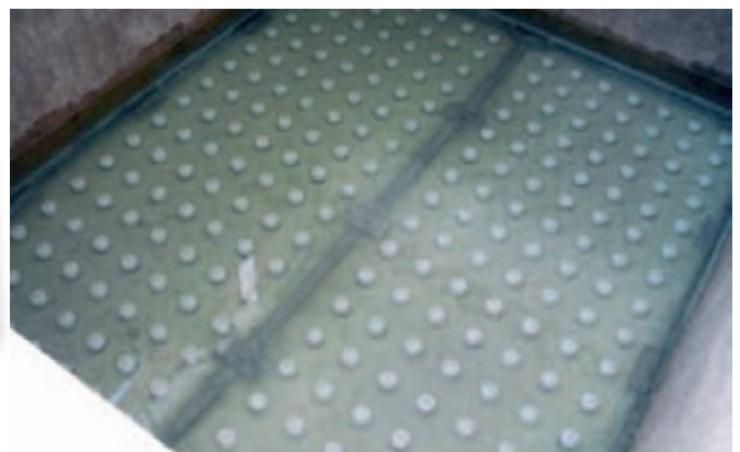
Plancher filtrant / station de Zelai
